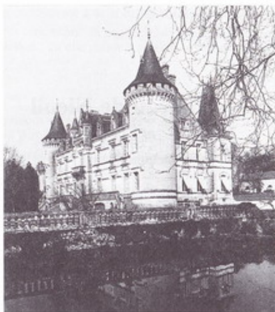
Nieul - Façades sud (à droite) et ouest
