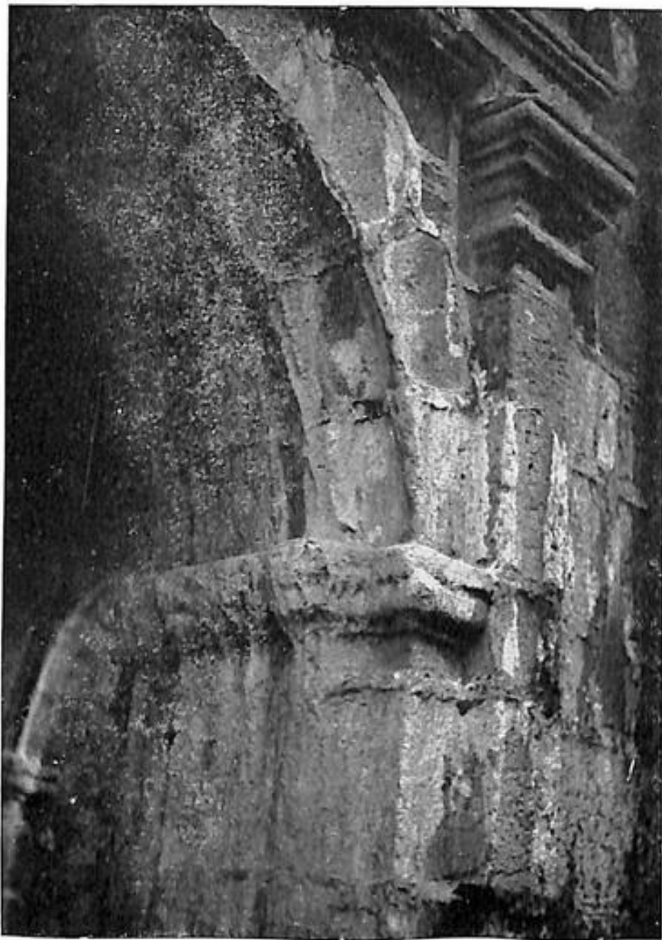
Fig. 11. - Eglise de Sizun -- Pilier extérieur droit du porche. La pierre est malade surtout à l'intérieur du porche ; l'attaque du chapiteau est très visible.
