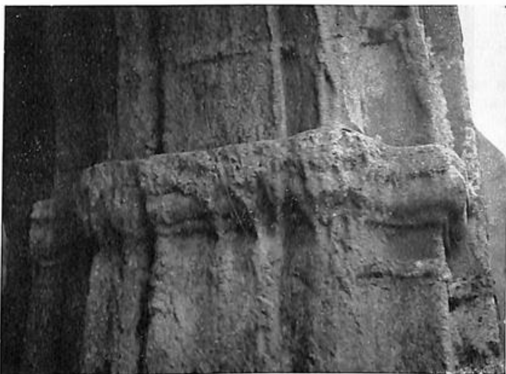
Fig. 12. - Eglise de Sizun. Détail du chapiteau de droite du porche. Remarquer le « fondu » des sculptures, la disparition du bandeau sur la face interne du porche ; par endroits, l'aspect « coulé » de la formation métasomatée, se déversant même du rebord supérieur du chapiteau (au milieu).
