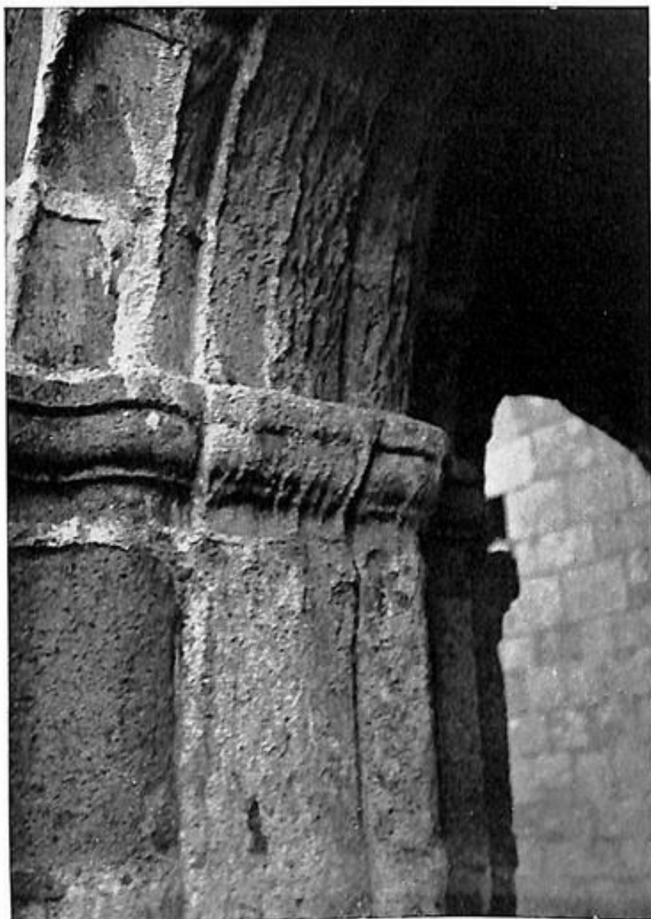
Fig. 13. - Eglise de Sizun. Vue du pilier gauche du porche. Il apparaît nettement que c'est la partie interne du porche qui est la plus atteinte.
