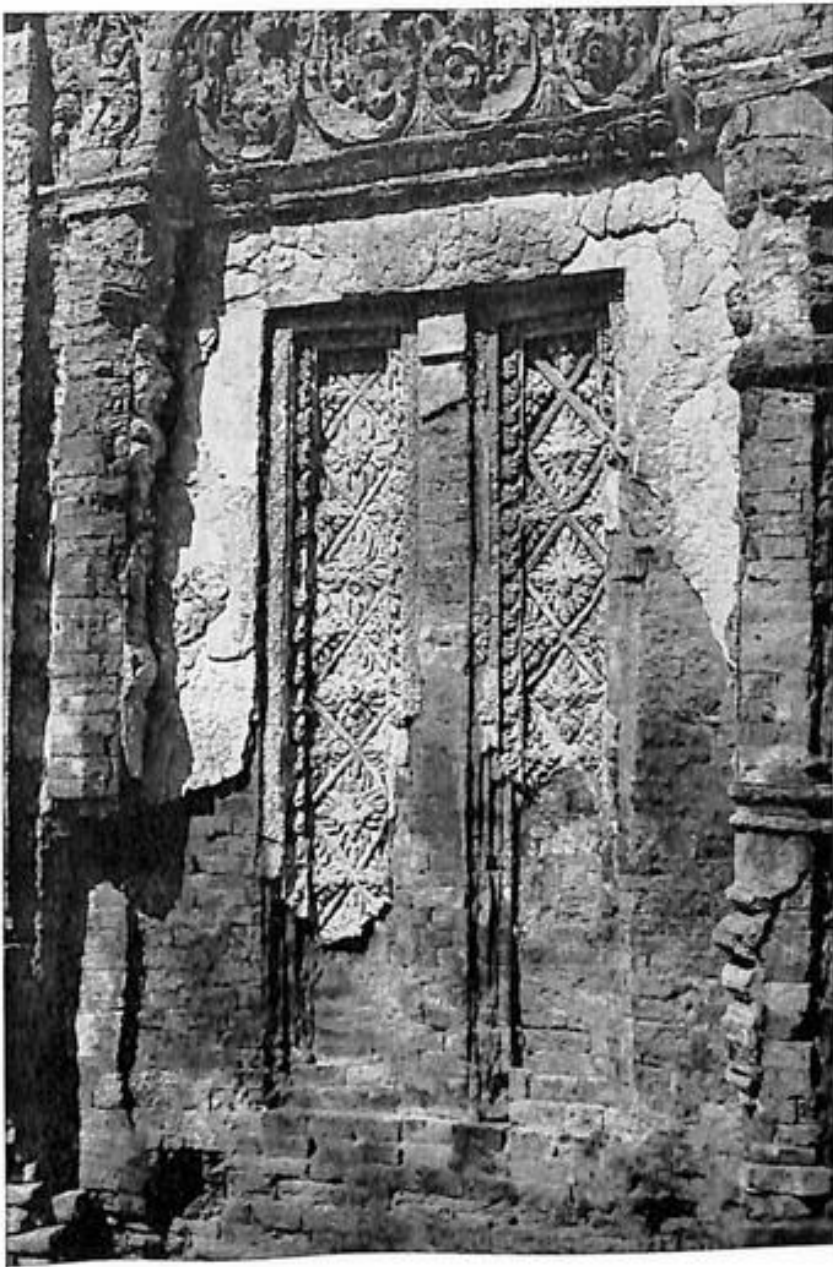
Fig. 6. - Preah Kô -- Tour nord-ouest -- Ici la construction est en briques recouvertes d'un décor en stuc. Des atteintes de la « maladie noire » sont visibles, par plaques.
