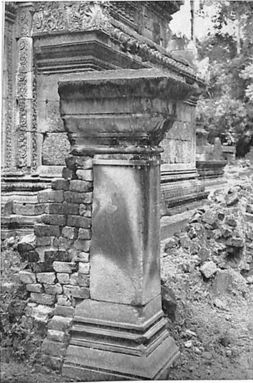
Fig. 4. - Banteay Srei - Pilier d'angle N. E. de la première enceinte : maladie noire diffusant selon les stratifications du grès.
